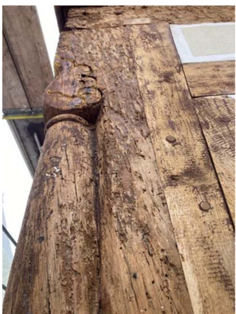
Eckständer während der Instandsetzung.
