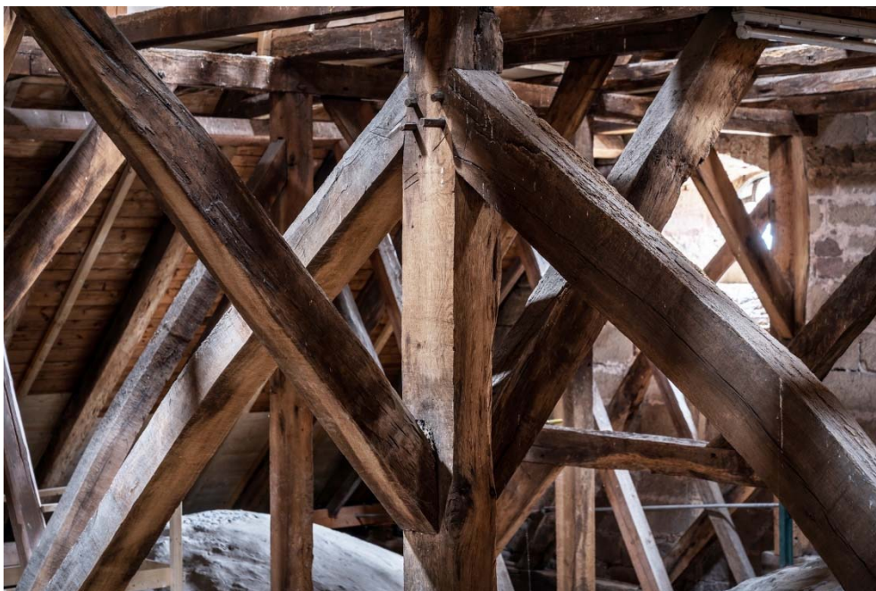
Die instandgesetzte Dachkonstruktion, Detailaufnahme.
