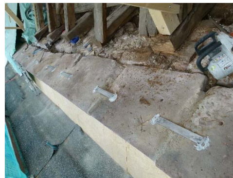
Lagesicherung und Verankerung der Traufgesimssteine auf der Mauerkrone.
