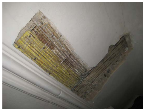
Vorhandene bzw. während der Dachinstandsetzung entstandene Risse in der Decke. Schließung der Risse in der Stuckdecke.
