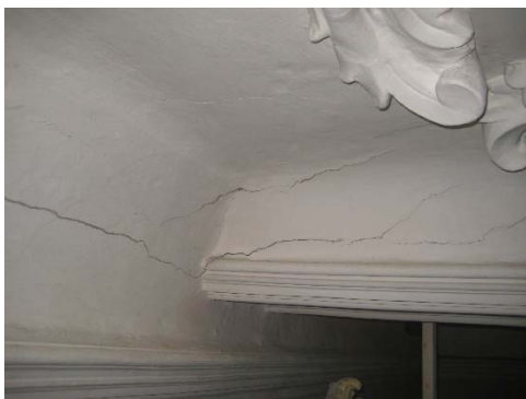
Vorhandene bzw. während der Dachinstandsetzung entstandene Risse in der Decke. Schließung der Risse in der Stuckdecke.
