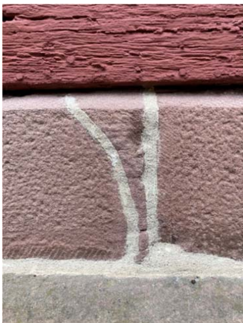
Sockel nach der Instandsetzung mit Fasse zur Schwelle zur besseren Wasserableitung.
