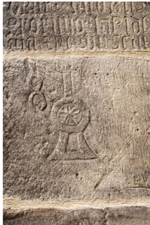
Mittelalterliche Darstellung eines Baukrans an einem Pfeiler auf der Südseite.
