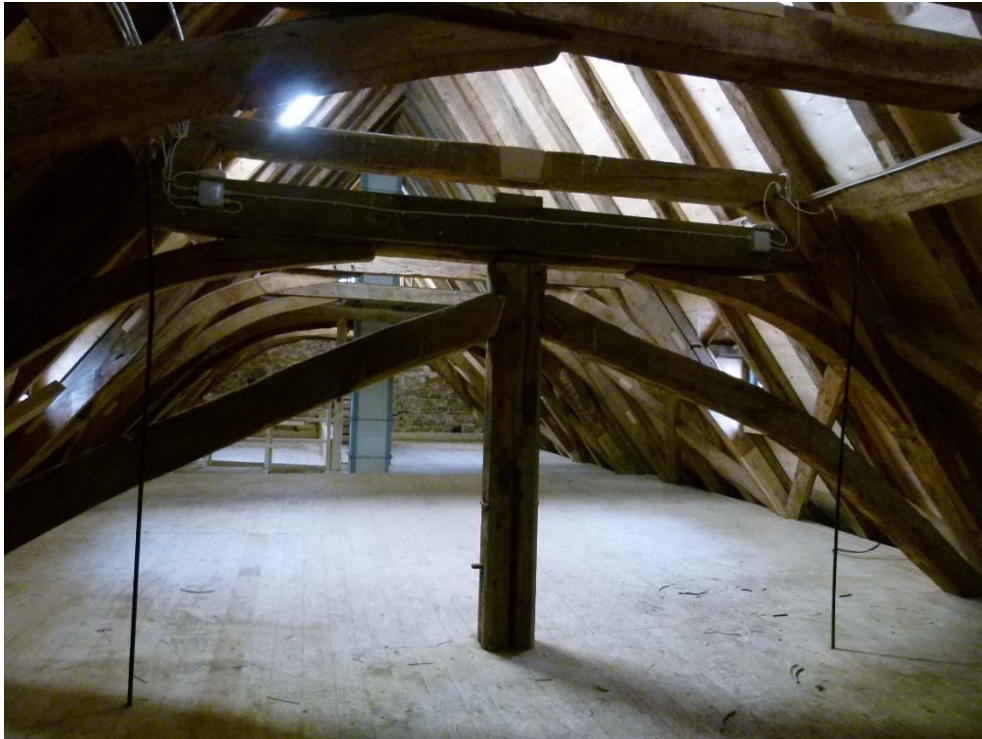
Dachkonstruktion über dem Langhaus nach erfolgter Instandsetzung.
