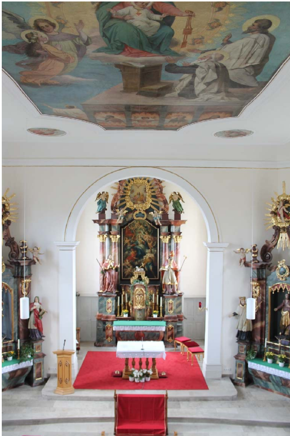
Nach der Restaurierung erstrahlt der Altarraum in einem hellen, warmen Licht.
