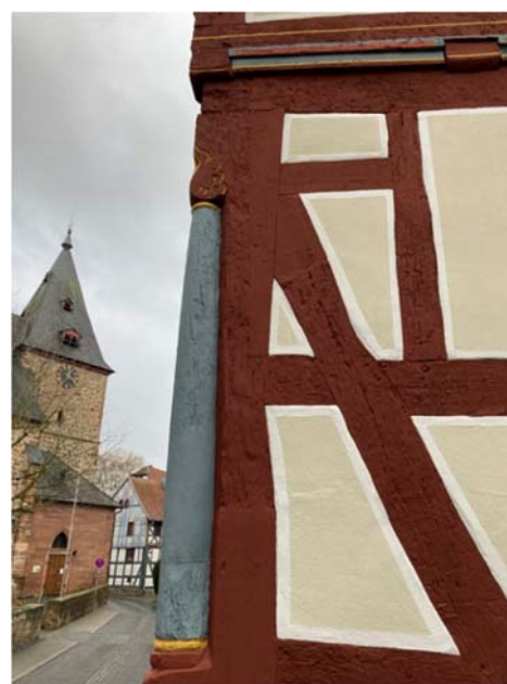
Eckständer nach der Instandsetzung.
