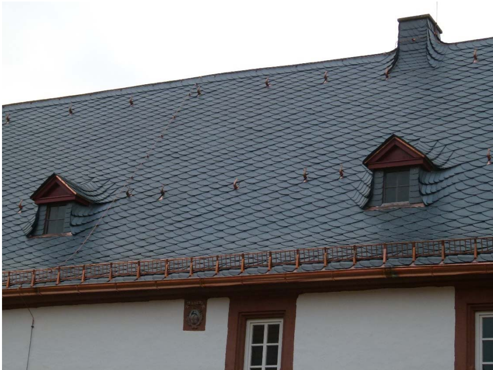
Mit Naturschiefer gedeckte Dachfläche mit eingebunden Gauben und Schornstein.
