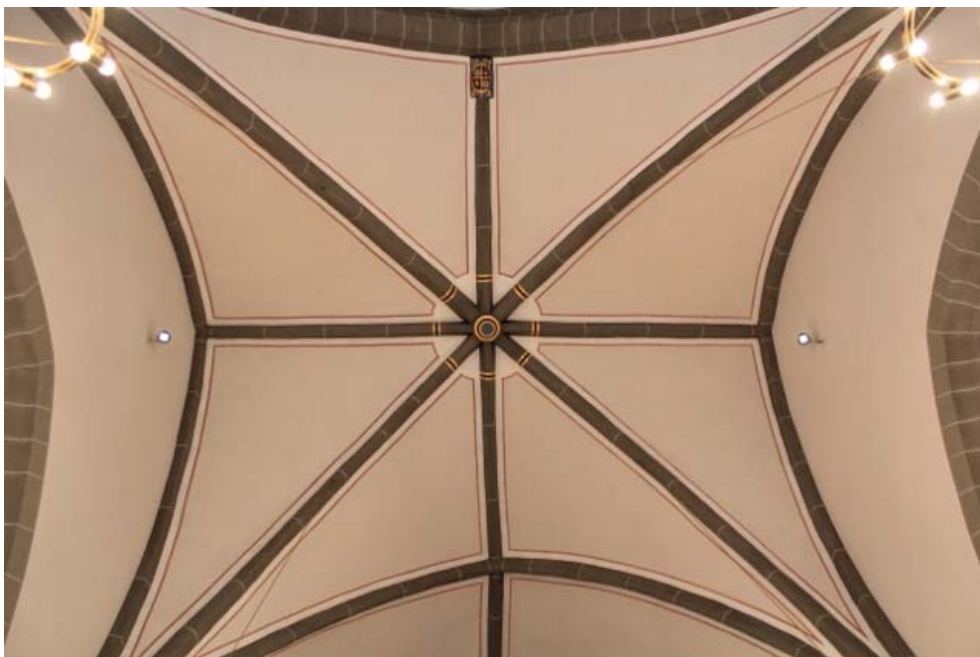
Die Raumschale nach der erfolgten Restaurierung.
