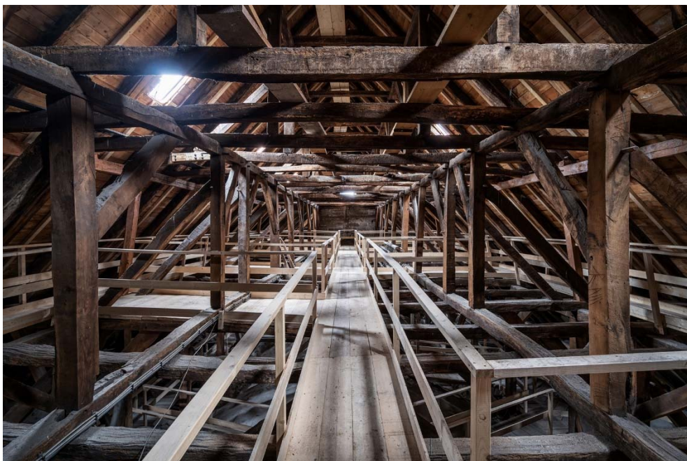
Die instandgesetzte Dachkonstruktion.
